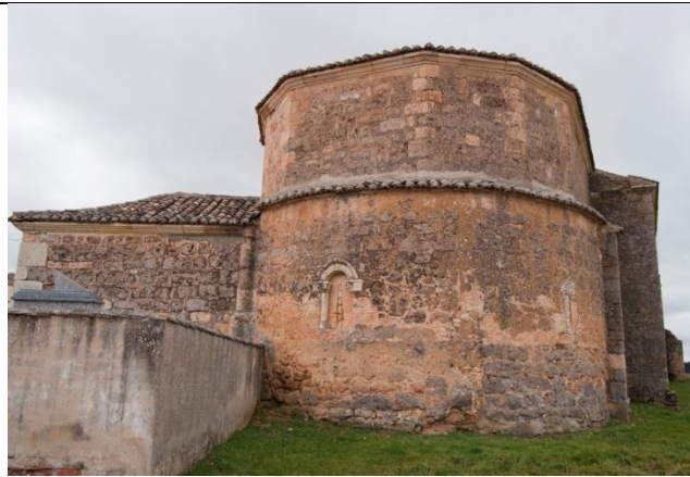
Ábside de la iglesia, la parte inferior corresponde a la estructura del primitivo templo románico, así como las ventanas y columna adosada al ángulo de la actual sacristía. Sobre la estructura del primitivo edificio se levantó un cuerpo octogonal en el siglo XVIII.
